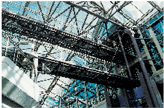
Pasarelas Centro Comercial Málaga Plaza.
