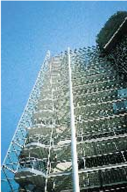
Escalera de incendios. Edificio Autopistas. Barcelona.
