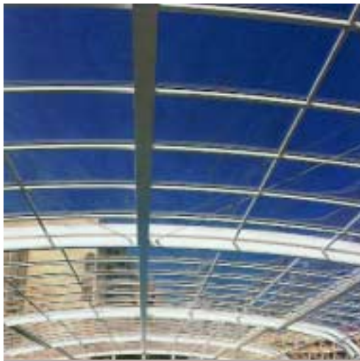
Refuerzo estructura. Cubiertas plegables.
