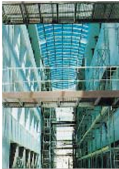
Nueva Sede de la Lotería Nacional. Madrid.
