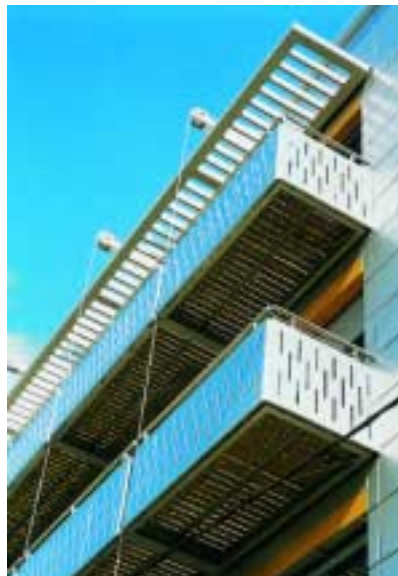
Tirantes balcones. Molins de Rei. Barcelona.
