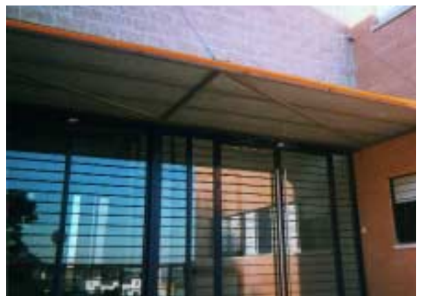
Marquesina Centro de Salud. Martos. Jaén.
