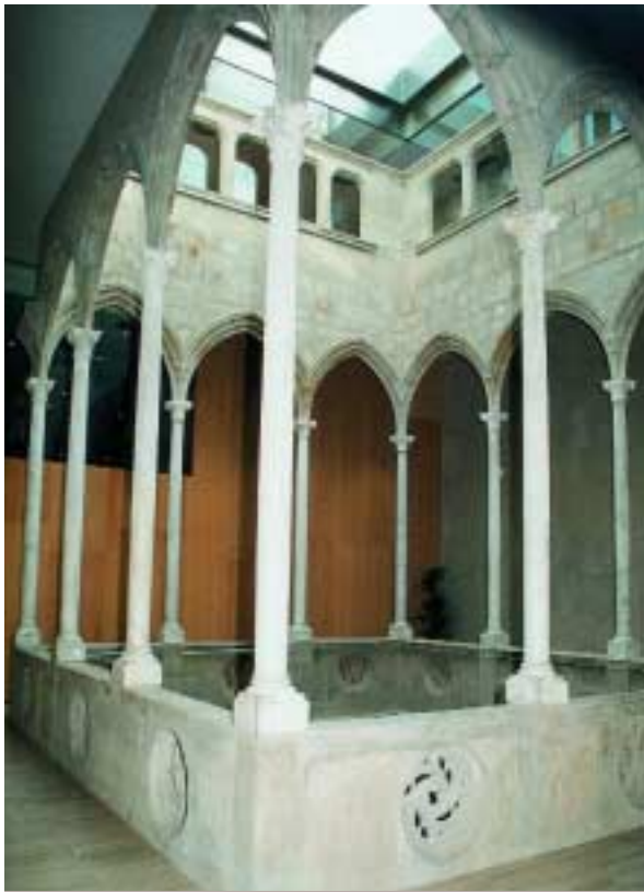
Claraboya claustro gótico. Edificio Prosegur. Barcelona.
