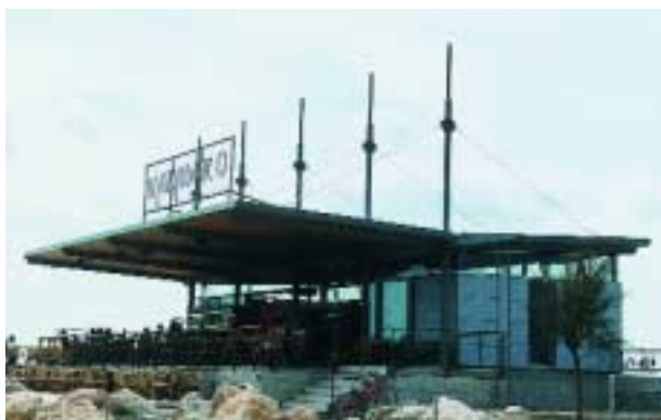
Estructura Estación Marítima. Palma de Mallorca.
