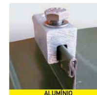
As coberturas de junta elevada apresentam diversos perfis construtivos. Dever-se-á utilizar o grampo de fixação adequado para cada modelo.
